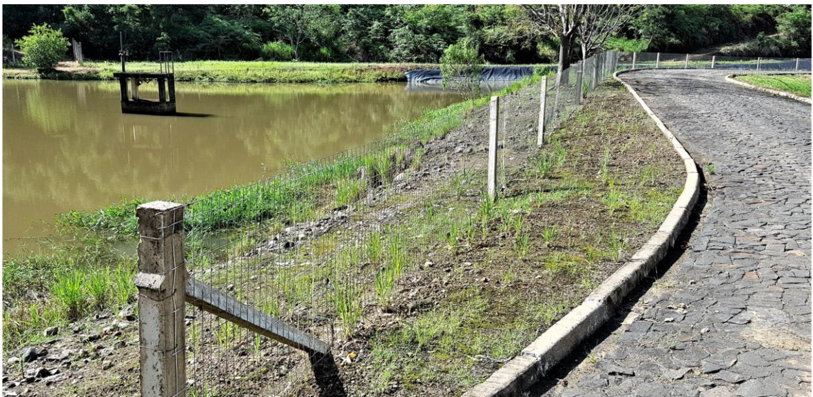
08. Acesso interno da PCH, passando ao lado do Canal de Adução, e a proteção à fauna silvestre
