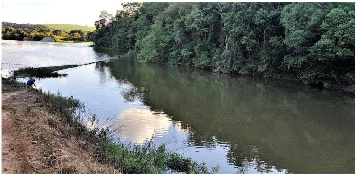
02. Canal de aproximação ao emboque do túnel e sua rede de retenção de flutuantes
