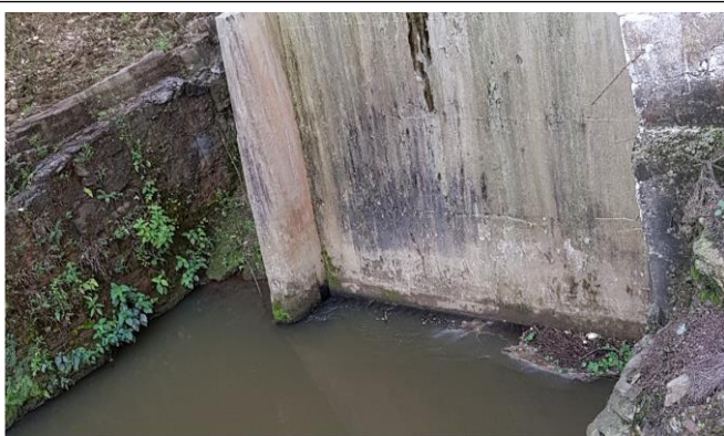
03. Emboque do túnel da PCH Pesqueiro
