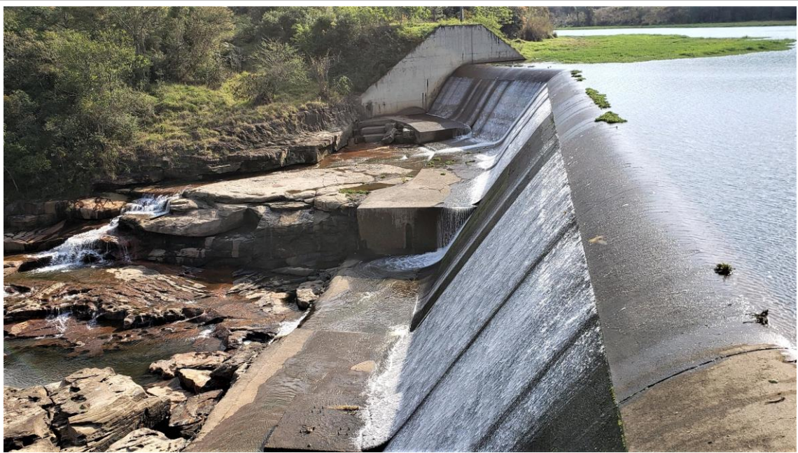
Figura 8: Barramento da PCH com seu vertedouro livre em sua crista, por onde flui o volume excedente
