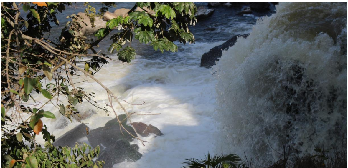
08. Caixa de restituição das águas da PCH Pesqueiro
