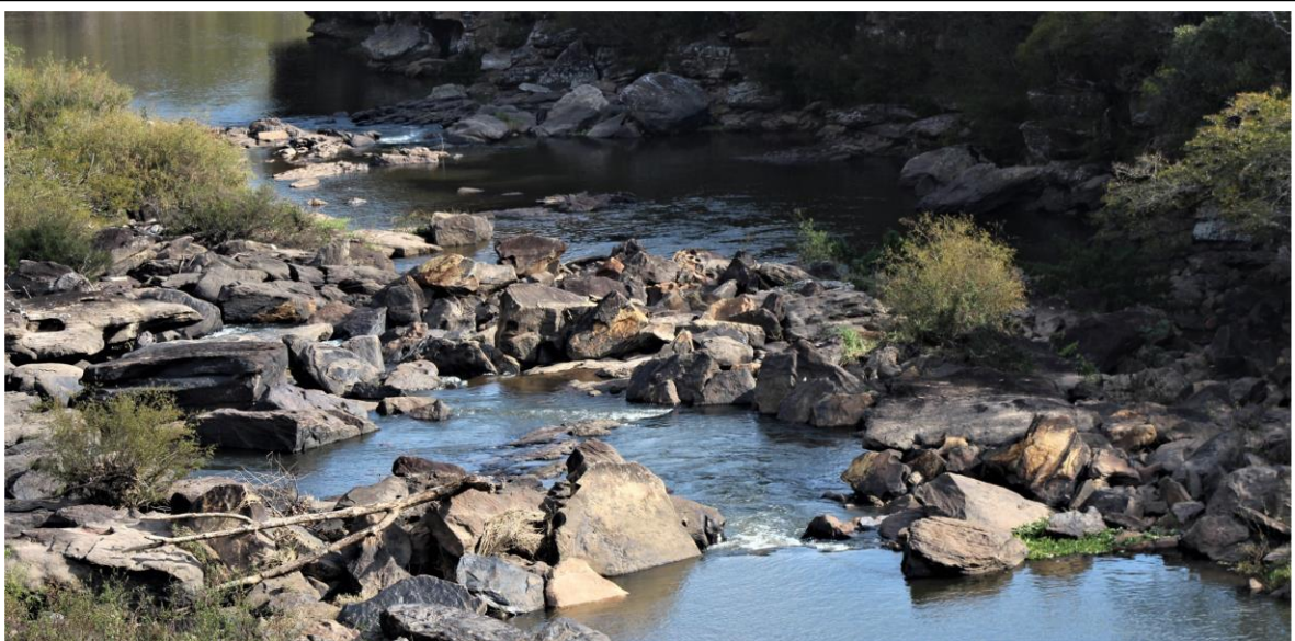
09. Início do TVR – Trecho de Vazão Reduzida da PCH Pesqueiro
