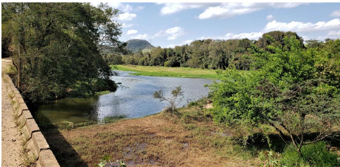
01. Reservatório da PCH Pesqueiro visto da ponte sobre o rio Jariva
